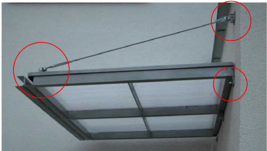
Rys. 2. Przykład mocowania daszku do ściany.
